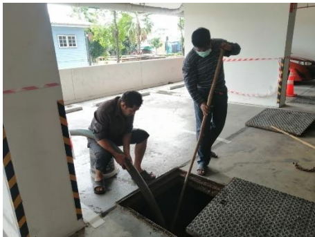
การสูบลากตะกอน/ไขมันส่วนเกินระบบบำบัดน้ำเสีย
