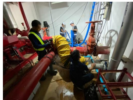
เจ้าหน้าที่ล้างทำความสะอาดถังเก็บน้ำสำรอง
