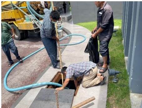
การสูบลากตะกอน/ไขมันส่วนเกินระบบบำบัดน้ำเสีย
