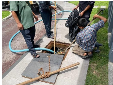
การสูบลากตะกอน/ไขมันส่วนเกินระบบบำบัดน้ำเสีย
