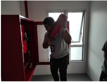
เจ้าหน้าที่ตรวจเช็คถังเคมีดับเพลิง
